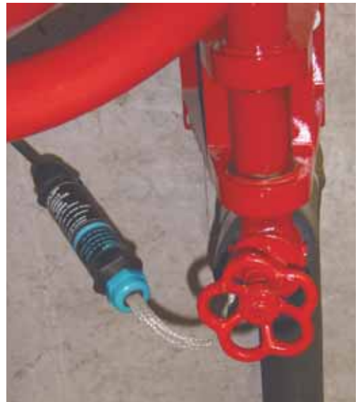
Protection de canalisations
